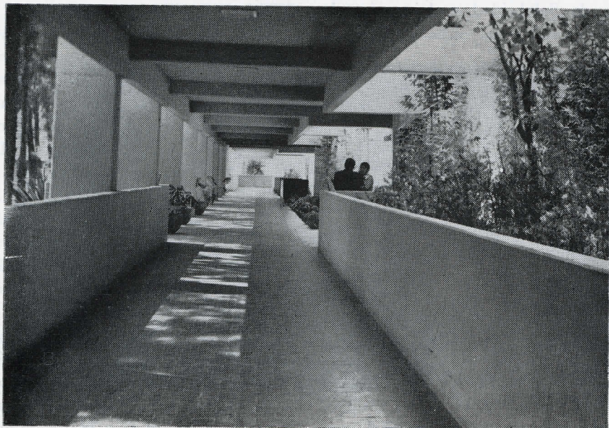
Paso cubierto del Servicio de Hospitalización.
