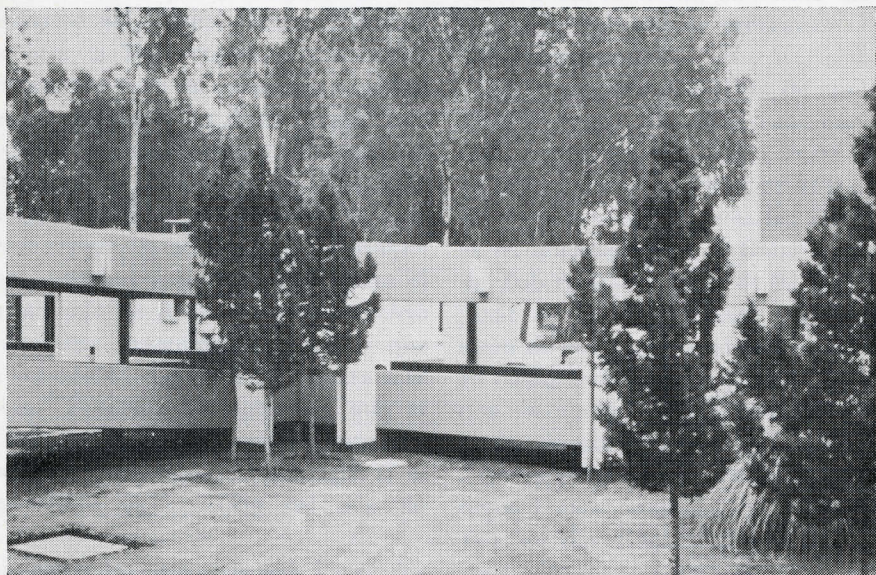
Paseo cubierto del edificio de Consulta Externa.
