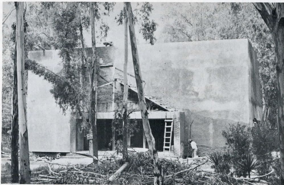
Construcción de la nueva Farmacia del instituto.
