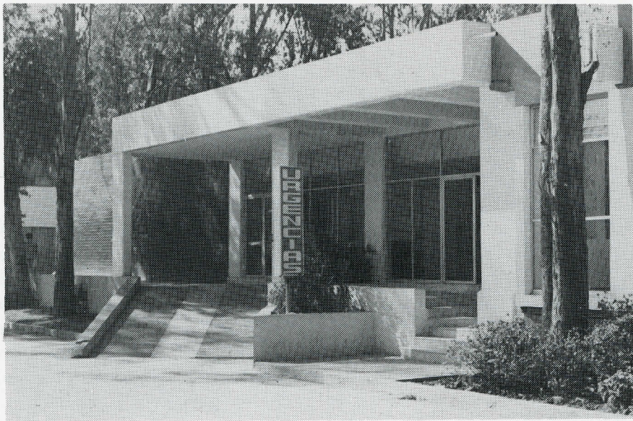
Este año se terminó la remodelación del Servicio de Urgencias, que forma parte del bloque del Área de Consulta Externa.
