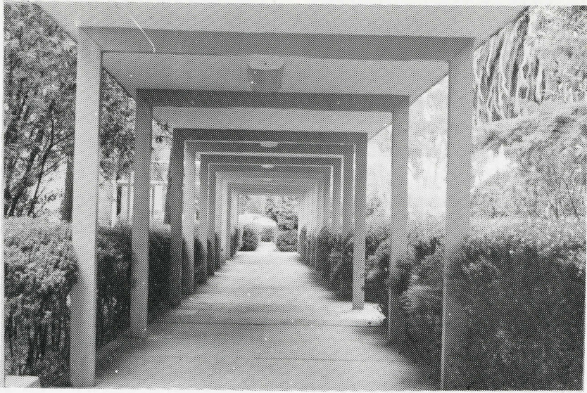
Parte de la estructura del andador que comunica al laboratorio clínico con los servicios de hospitalización.
