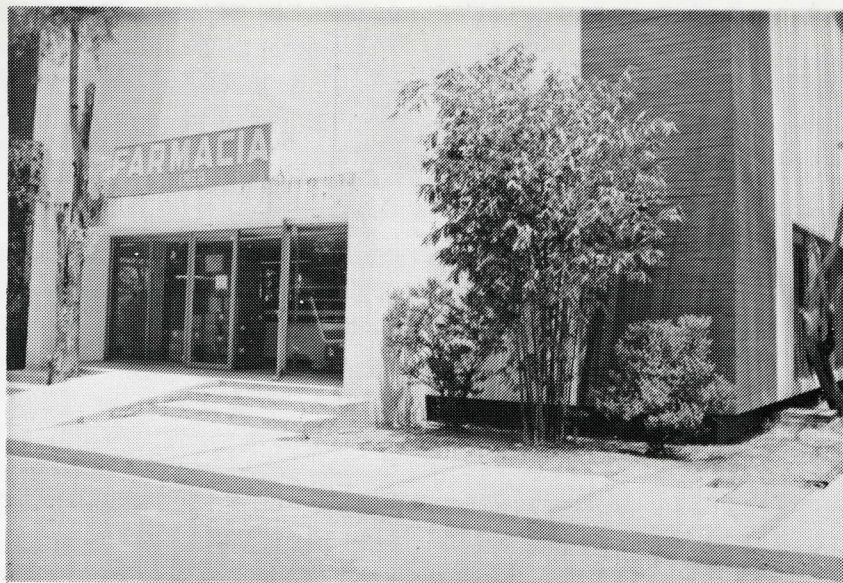
La construcción de la nueva farmacia permitió el abastecimiento adecuado de medicamentos.
