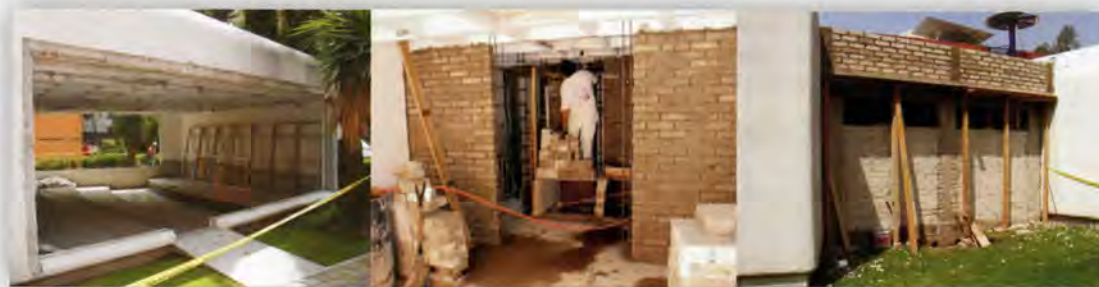
Vista de la obra de remodelación actual
